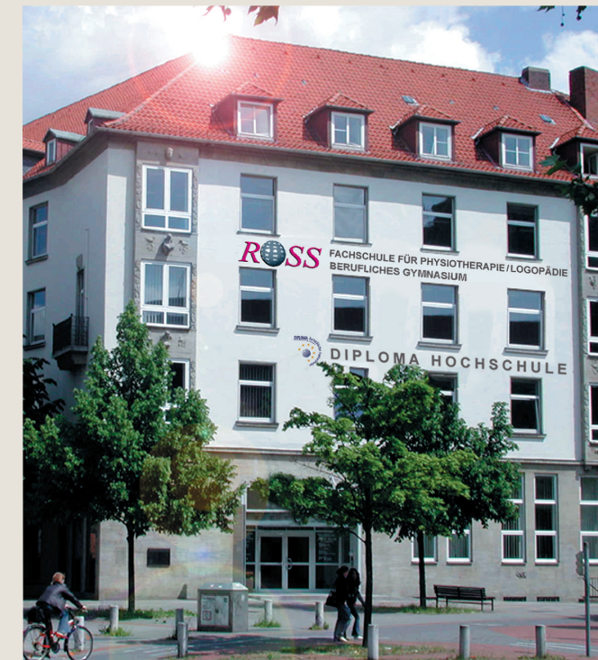
Schulgebäude der Ross-Schule
